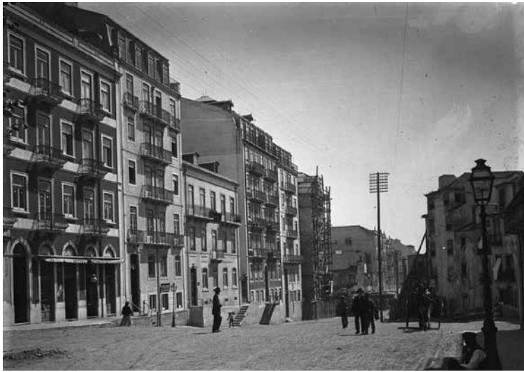
A – Vista da construção da avenida no local da antiga Igreja dos Anjos
